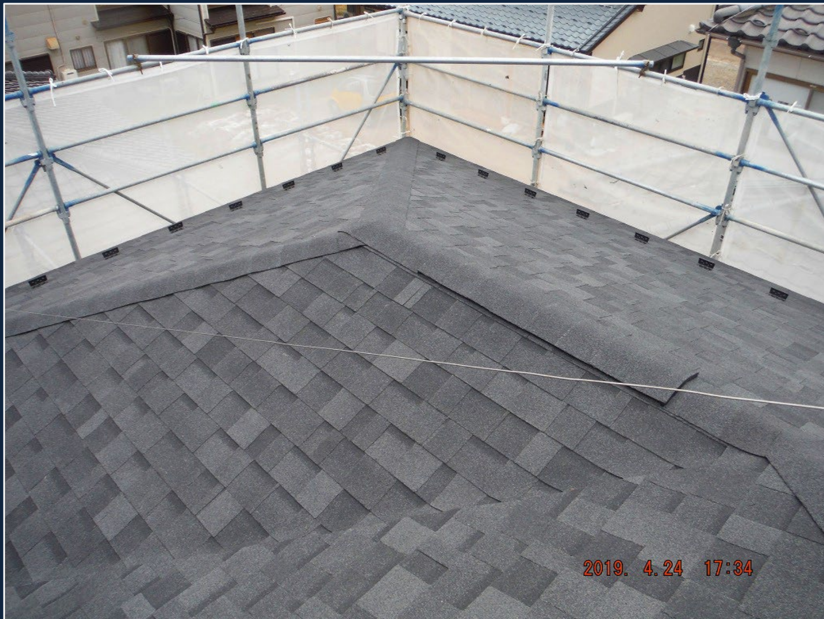
リッジウェイ 施工完了
